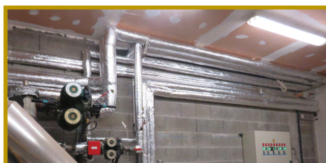
Isolation des chaufferies (école, salle des fêtes, mairie, vestiaire du stade, etc)
